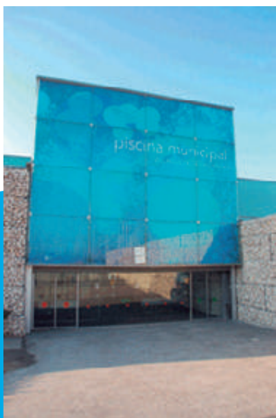
Entrada principal de la instalación
