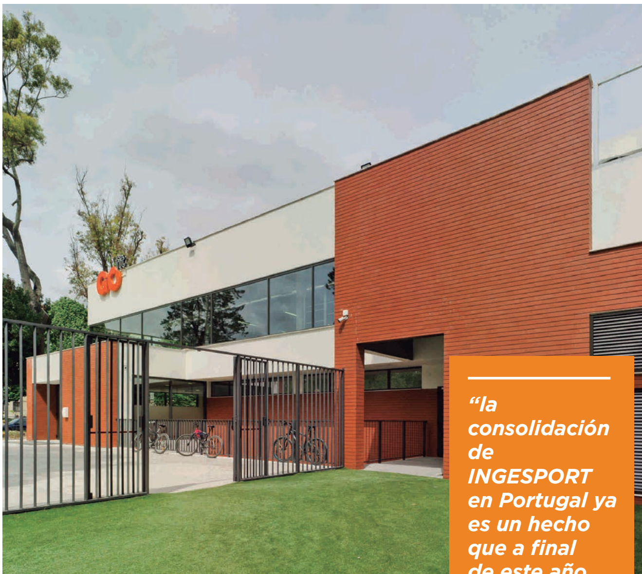
Acceso principal a la instalación
