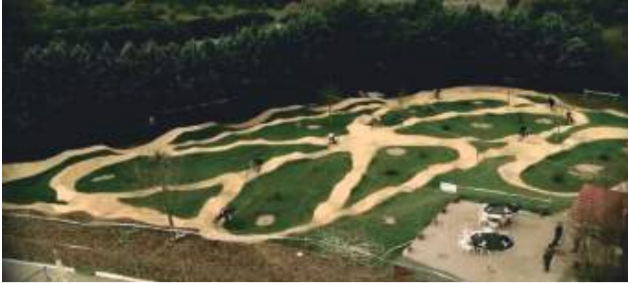
Pumptrack de tierra construido por la empresa Velosolutions
