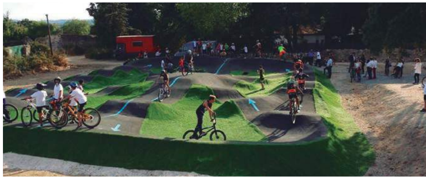
Pumptrack asfaltado realizado por NV Sports (El Escorial-Madrid)
