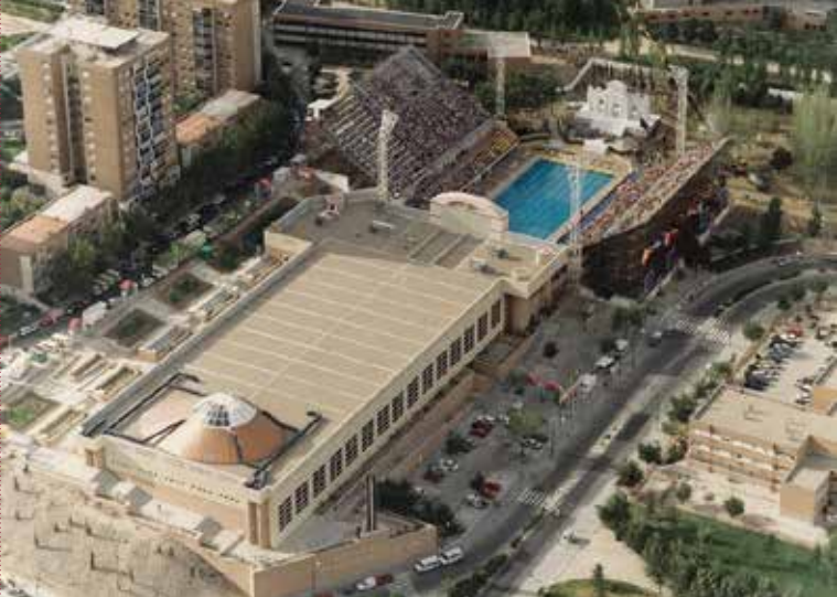
Vista aérea del Centro de Natación con los graderíos provisionales.
